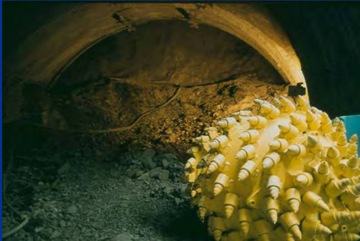
Fräskopf der Tunnelfräse
