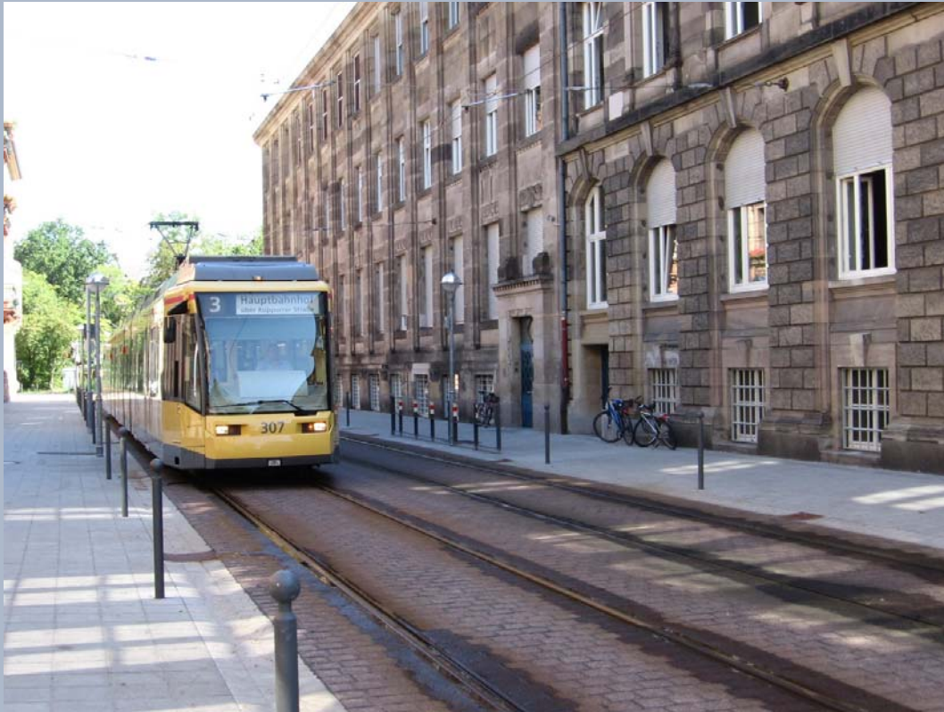
Grashofstraße wird zur reinen Straßenbahntrasse
