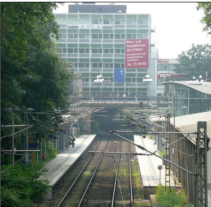
Abbildung: S-Bahn Haltestelle Dortmund Möllerbrücke
