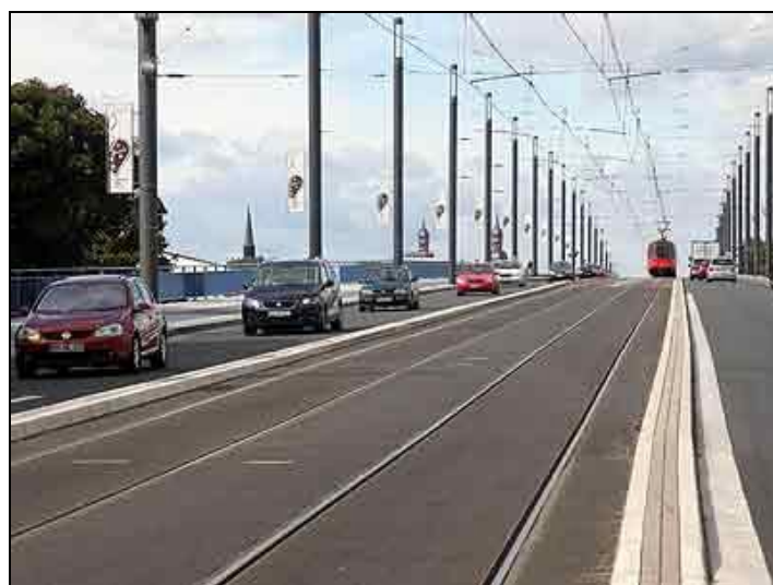
Abbildung 49: Kennedybrücke in Bonn nach dem Umbau
