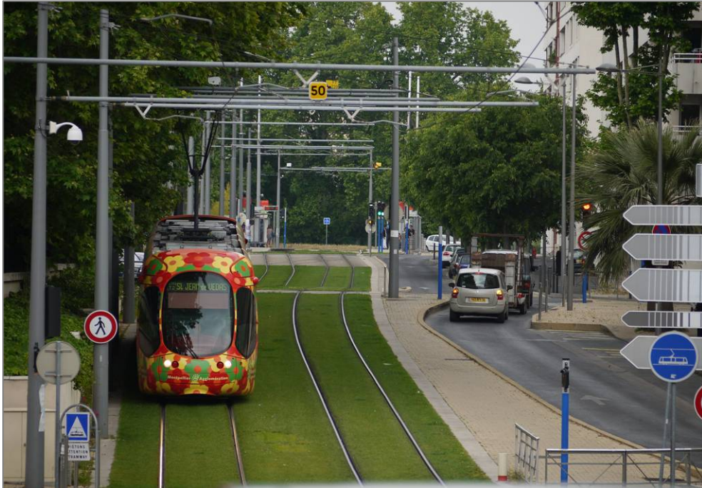
Abbildung 12: Beispiel eines Rasengleises als Erweiterung eines durch Grünflächen geprägten Umfeldes (Montpellier)
