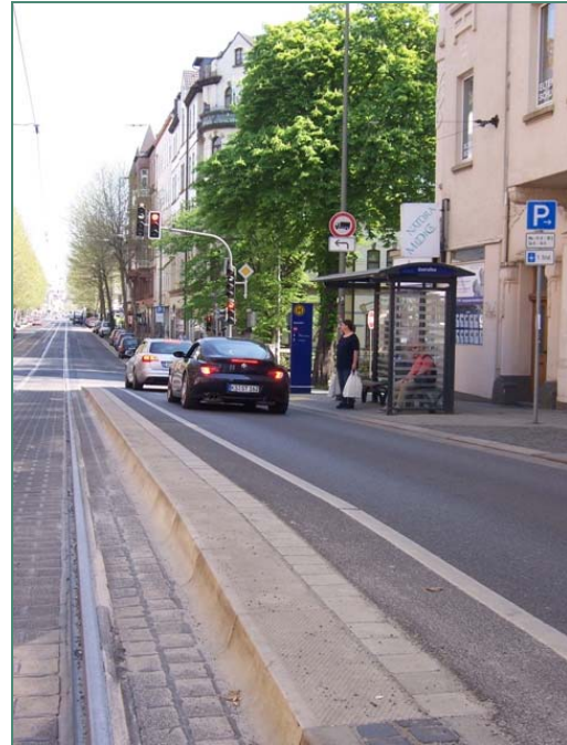
Abbildung 25: Temporärer Bahnsteig Kassel (Detailansicht Bahnsteigkante)
