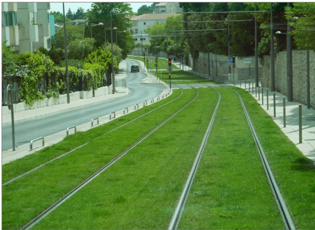
Abbildung 11: Beispiel einer Trassenführung als Rasengleises durch ein Wohngebiet (Montpellier)
