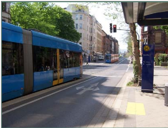
Abbildung 24: Temporärer Bahnsteig Kassel (Halt der Straßenbahn)
