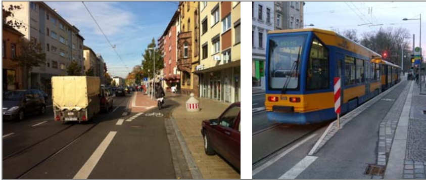
Abbildung 22: Beispiele für eine Radfahrerführung über den Bahnsteig (Freiburg, Leipzig)
