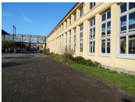
Abb. 9 Grünstreifen entlang des Jugendgästehauses mit vorgelagerter wassergebundener Wegedecke.
