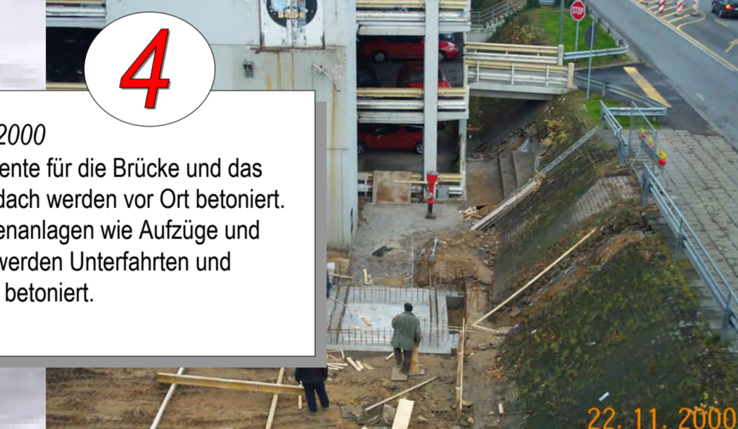
Fundamt und Schalung für den Aufzug an der Südseite
