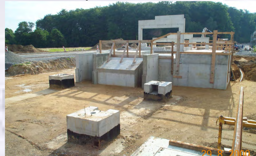
Fundamente für die Verbindungsbrücke und der Betriebsraumkeller
