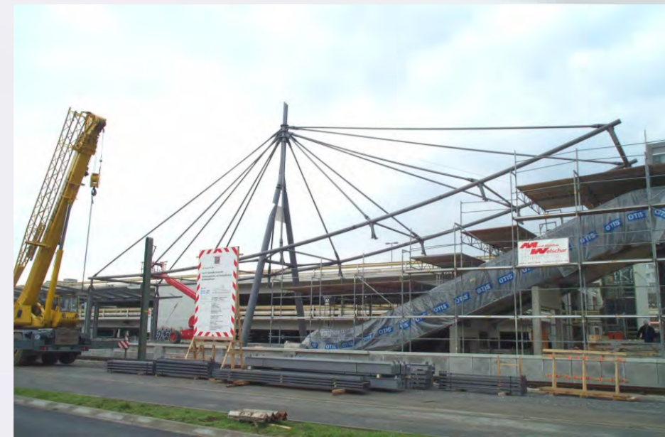
Pylon mit angehängtem Traggerüst
