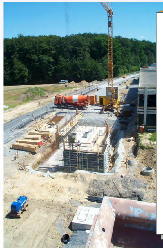
Aufstellen der Schalung für den Betriebsraumkeller
