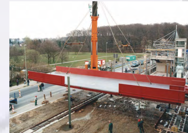
Aufsetzen der Tröge auf die Stützen
