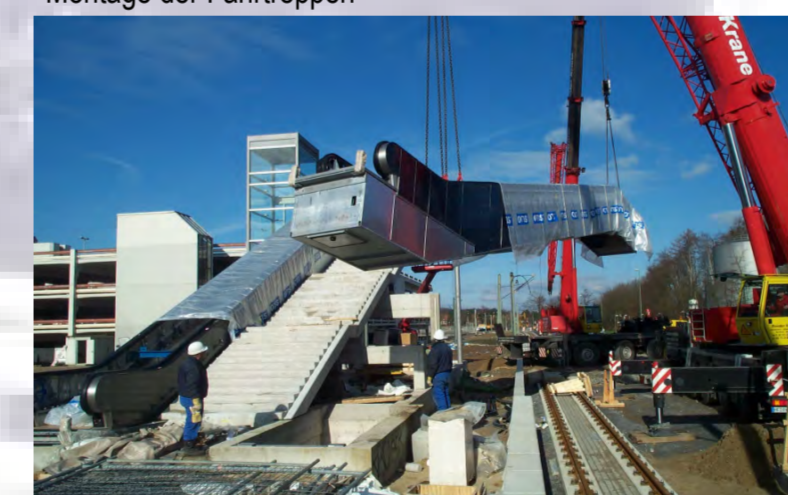
Montage der Fahrtreppen
