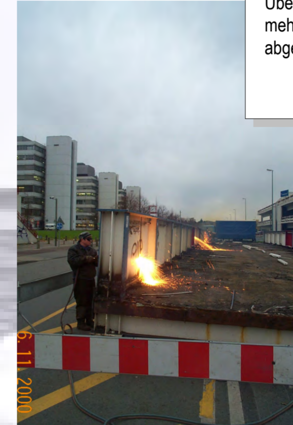
Die alte Brücke wird zum Transport zerlegt
