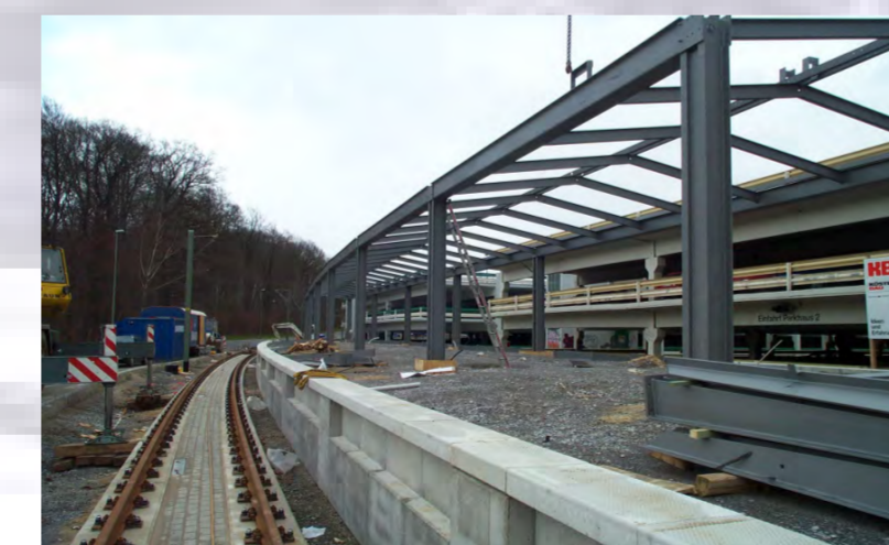
Gerüst Haltestellendach im Stützenbereich
