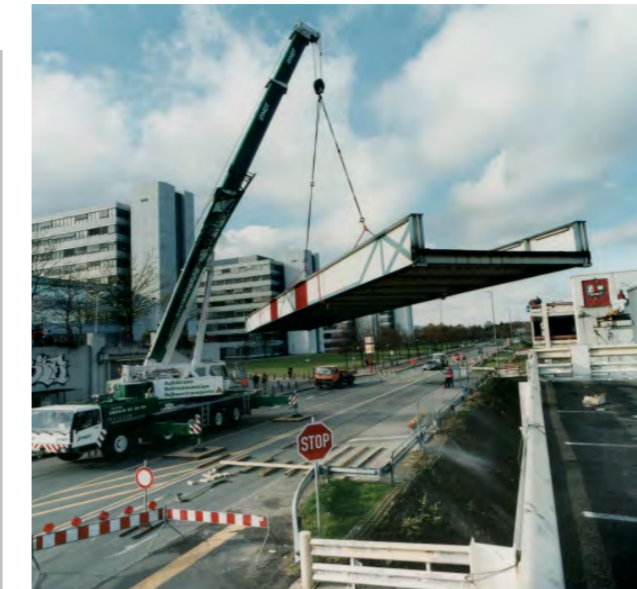
Die alte Brücke wird abgehoben
