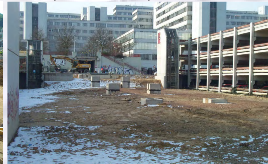
Fertigteilfundamente für die Verbindungsbrücke
