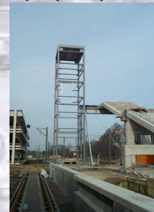
Gerüst Haltestellendach im Stützenbereich
