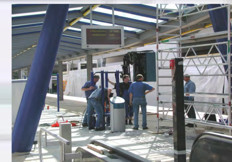
Möblierung des Bahnsteiges
