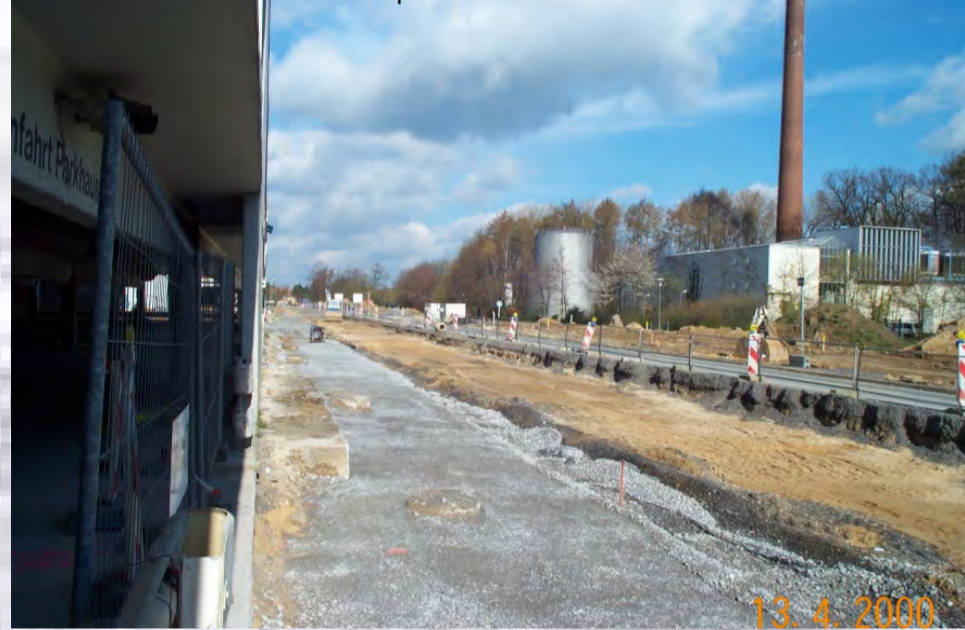
Bodentausch im Bereich der späteren Haltestelle
