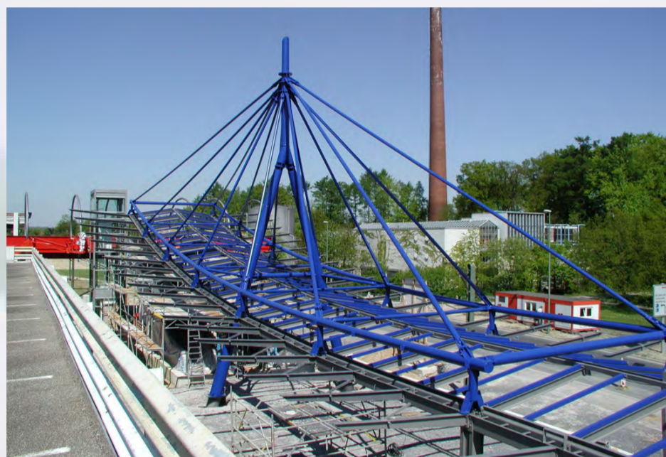
Pylon mit Farbbeschichtung
