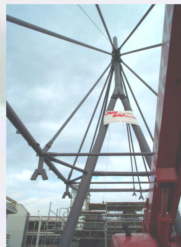
Pylon mit angehängtem Traggerüst
