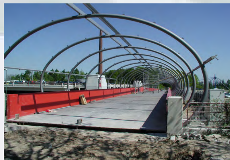
Montage der Rundbögen und Pfetten
