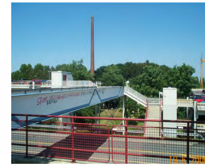
Die alte Brücke zu den Parkhäusern
