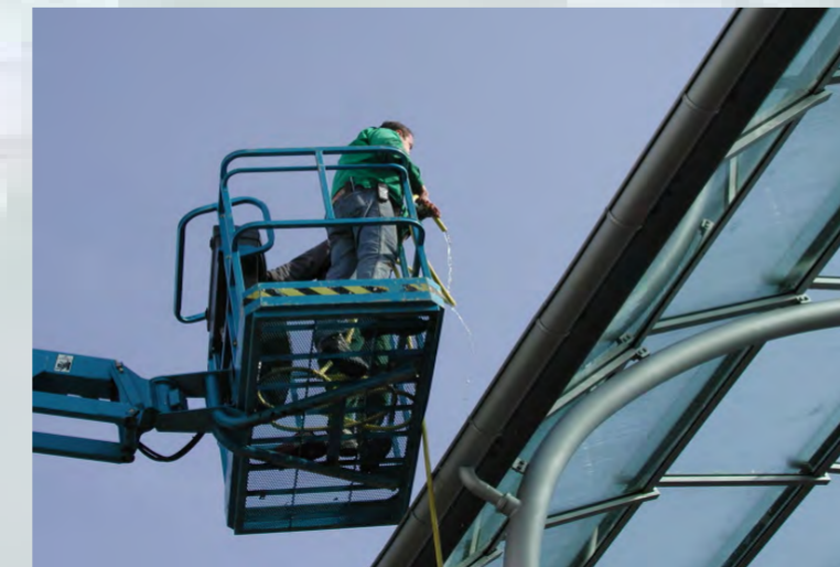
Einsetzen der Glasscheiben
