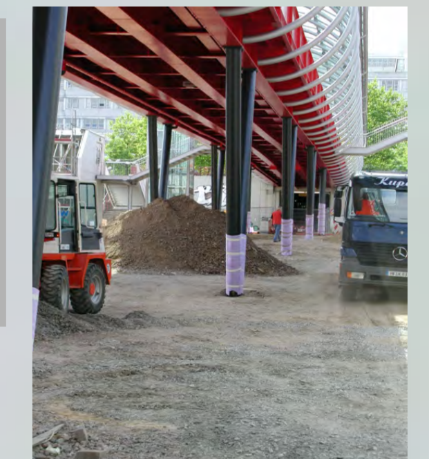
Anschüttung des Rampenweges
