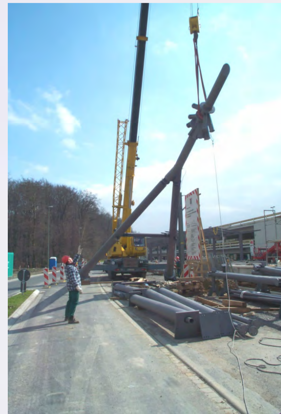
Aufrichten des Pylons
