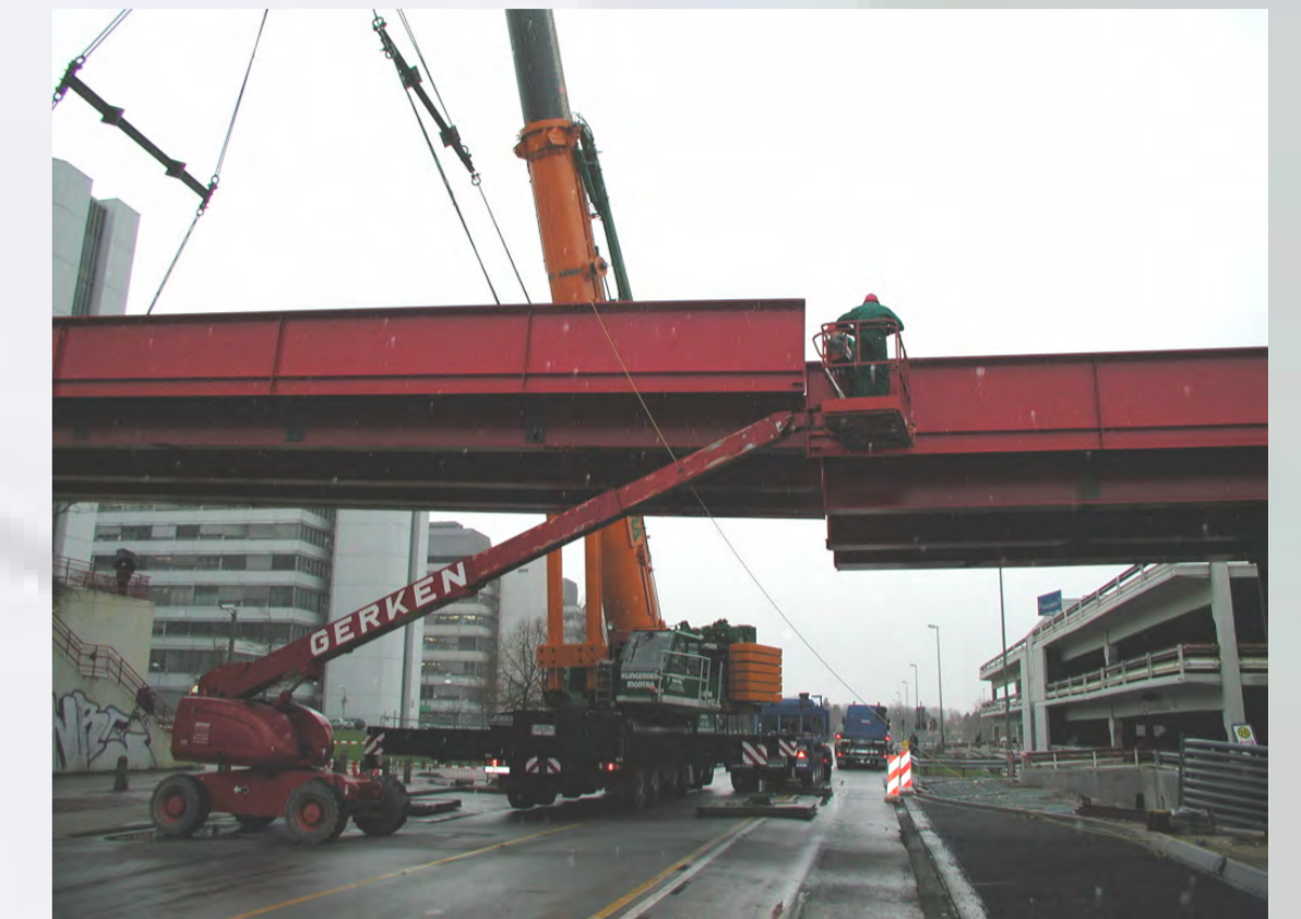
Verschrauben der Brückentröge
